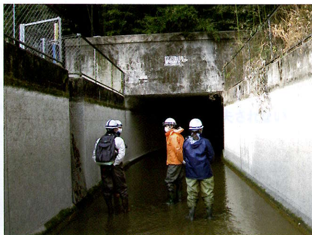
▲井山隧道点検
