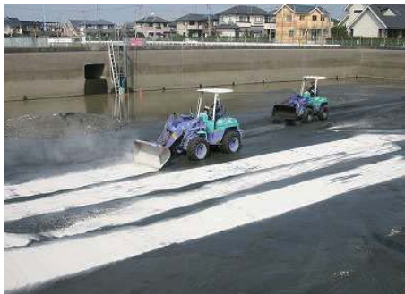
ファームポンド堆積土の管理
