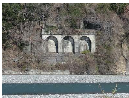
旧取水口を BCP 整備(産業遺産登録)
