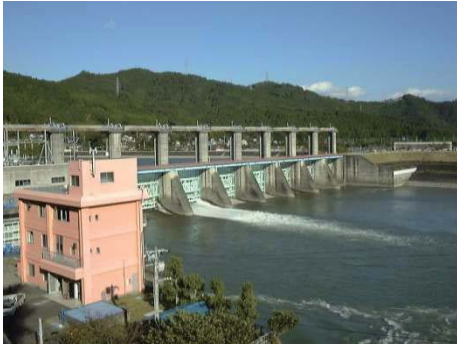
船明ダム 天竜川の取水施設
