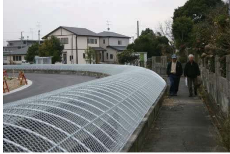
ドーム型ネットフェンス設置
