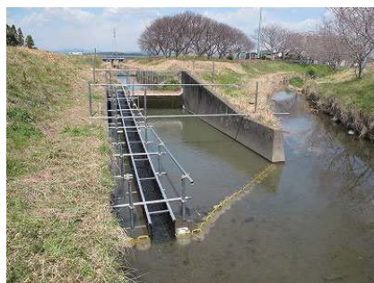
水田魚道の設置
