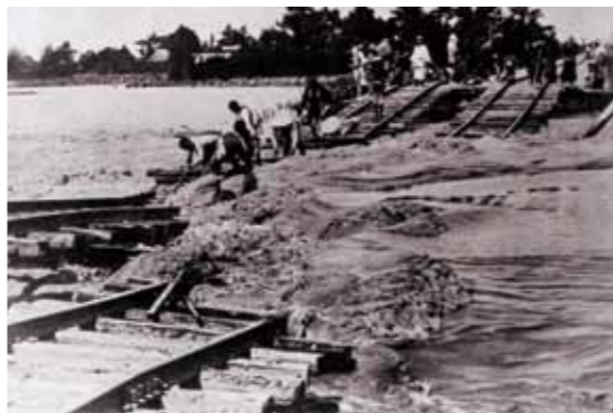
明治44年8月の豪雨による東海道本線崩落(井通村) 出典：『磐田の記録写真 第二集 磐田の産業』
